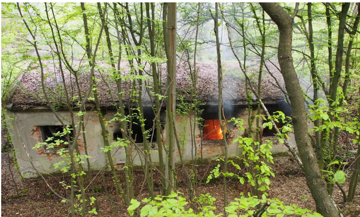
Požiar budovy v obci Ruskov
